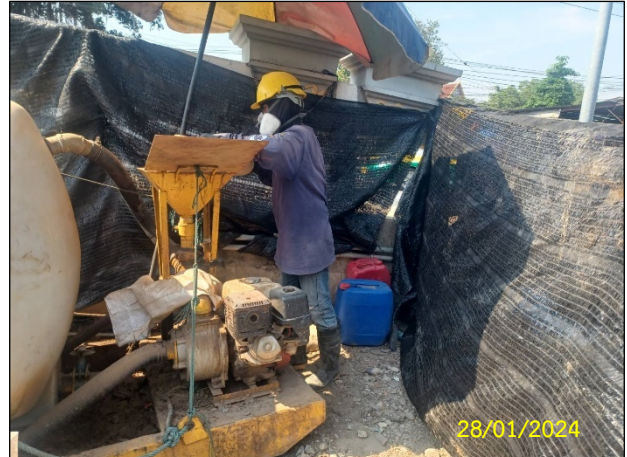
ฉ) ปิดปกคลุมบริเวณพื้นที่ผสมโซเดียมเบนโทไนท์ เพื่อป้องกันฝุ่นละออง
