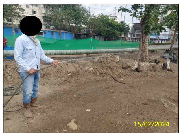
รูปที่ 2-5 ตัวอย่างการฉีดพรมน้ำบริเวณพื้นที่ก่อสร้าง
