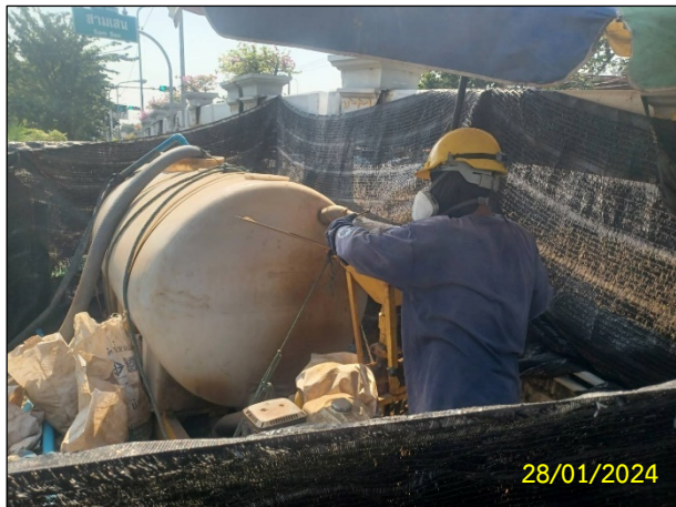
ฉ) ปิดปกคลุมบริเวณพื้นที่ผสมโซเดียมเบนโทไนท์ เพื่อป้องกันฝุ่นละออง
