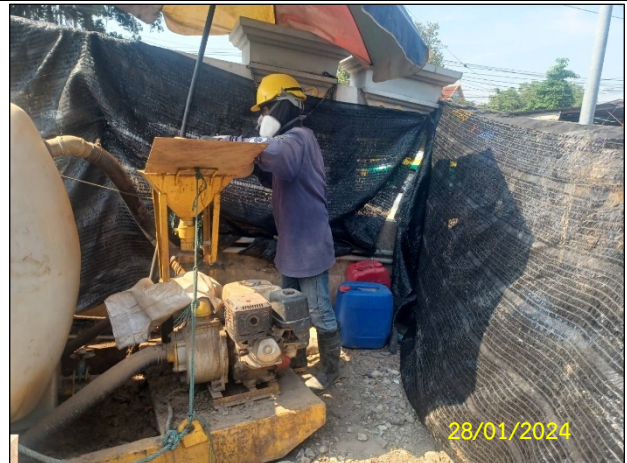
ง) เจ้าหน้าที่ผสมโซเดียมเบนโทไนท์เพื่อใช้ในการเจาะลุด
