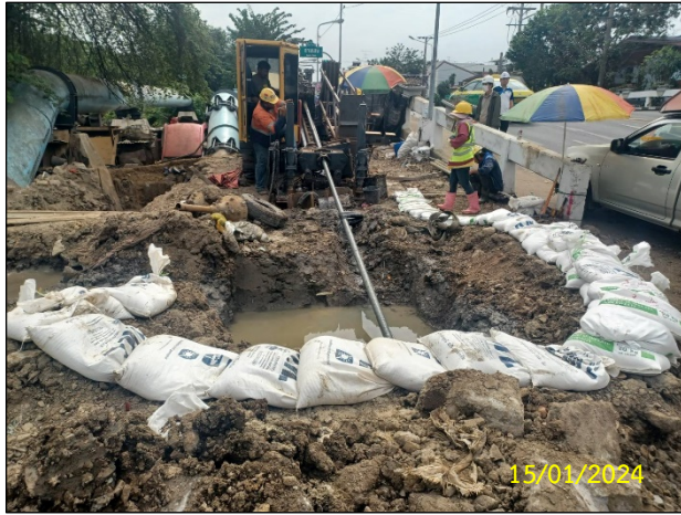
ก) การวางถุงทราย/จัดทำคันดินโดยรอบบ่อรับ-บ่อส่ง เพื่อป้องกันการปนเปื้อนของโคลนโซเดียมเบนโทไนท์
