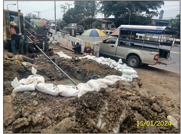
ก) การวางถุงทราย/จัดทำคันดินโดยรอบบ่อรับ-บ่อส่ง เพื่อป้องกันการปนเปื้อนของโคลนโซเดียมเบนโทไนท์
