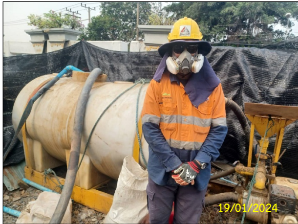
ง) เจ้าหน้าที่ผสมโซเดียมเบนโทไนท์เพื่อใช้ในการเจาะลุด
