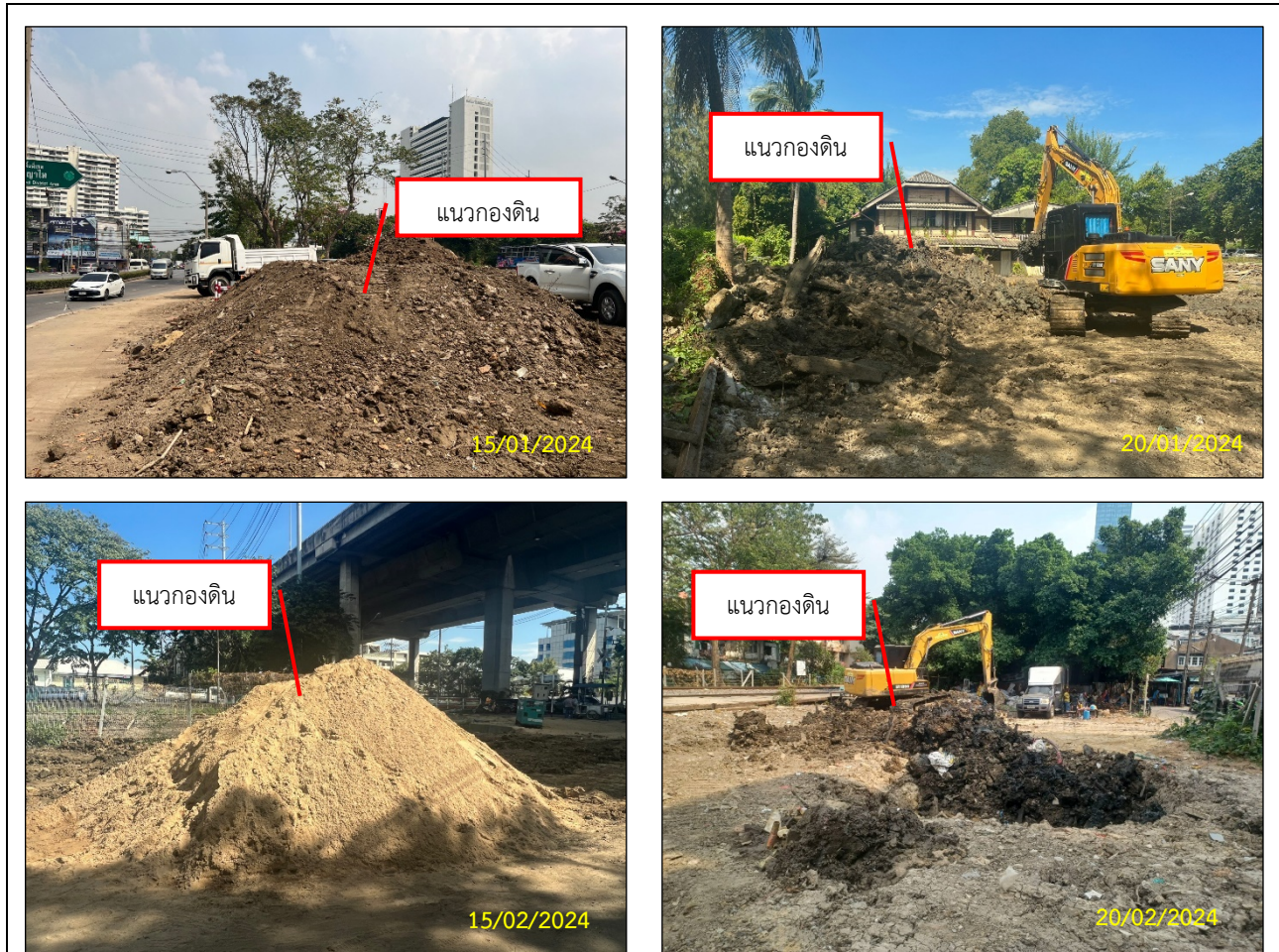
รูปที่ 2-18 จัดวางกองดินไม่กีดขวางทางระบายน้ำในพื้นที่ และอยู่ห่างจากแหล่งน้ำ อย่างน้อย 15 เมตร
