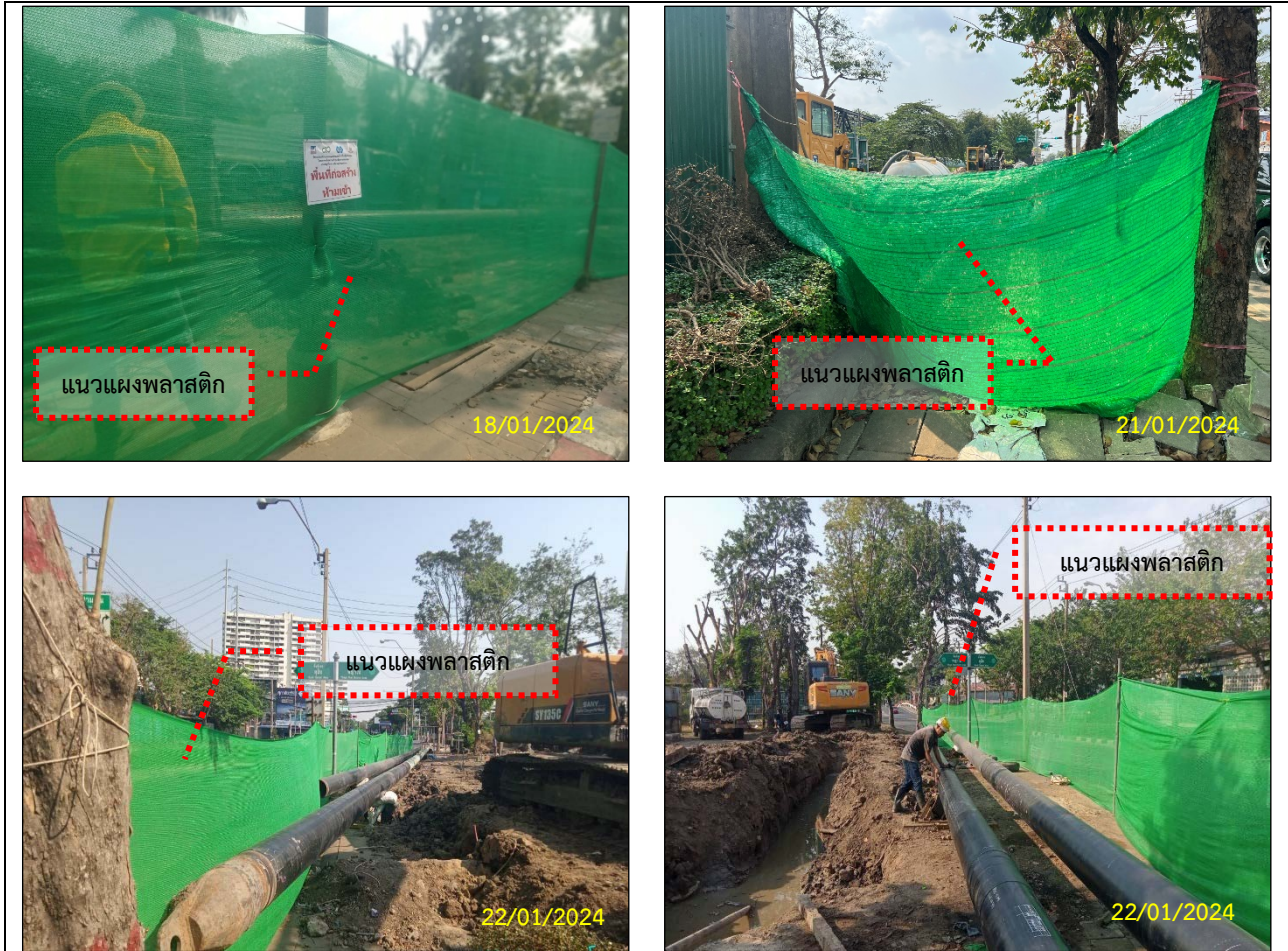
รูปที่ 2-8 การติดตั้งแผงพลาสติกป้องกันการฟุ้งกระจายของฝุ่นละออง
